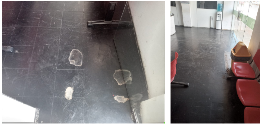
Imagem 3 e 4 – Piso vinílico original desgastado. (SET/2021)
