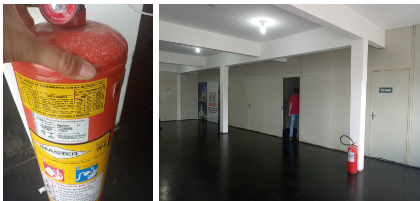
Imagem 14 e 15 – Recarga, suporte e demarcação dos extintores a serem executados. (SET/2021)
