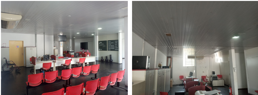
Imagem 8 e 9 – Luminárias LED queimadas. (SET/2021)
