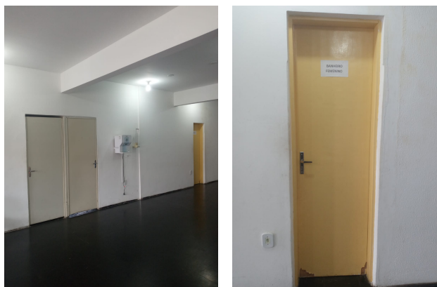
Imagem 16 e Imagem 17 – Necessidade de execução da comunicação visual. (SET/2021)
