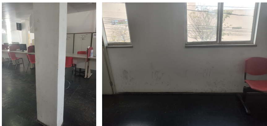
Imagem 10 e 11 – Pintura a ser executada. (SET/2021)
