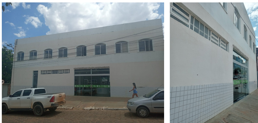
Imagem 1 e 2 – Fachada Principal. (SET/2021)
