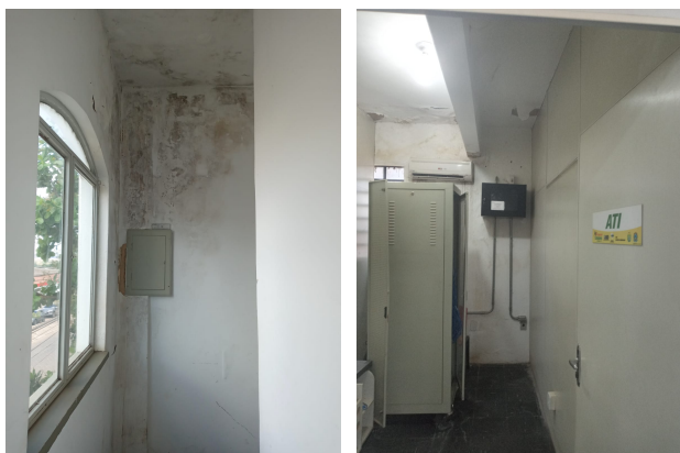
Imagem 12 e 13 – Infiltrações a serem sanadas. (SET/2021)
