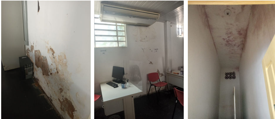
Imagem 5 a 7 – Infiltração nas paredes e laje. (SET/2021)
