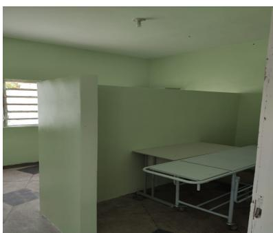
*Imagem 9 – meia divisórias para serem retiradas para ampliação das salas. (JAN/2021)*
